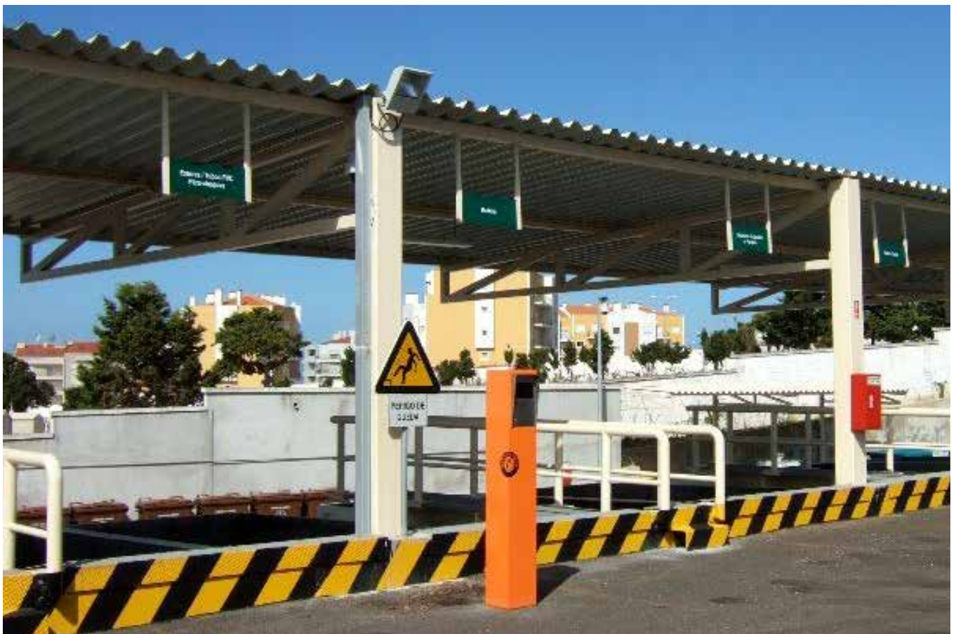
Plataforma de descarga de sucata
