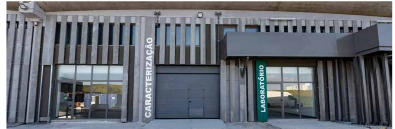
Laboratório e área de caracterização no Novo Edifício Social e de Serviços de Trajouce.
