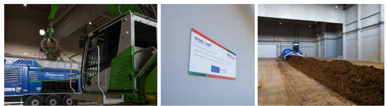
Nova Central de Compostagem de Resíduos Verdes de Trajouce.
