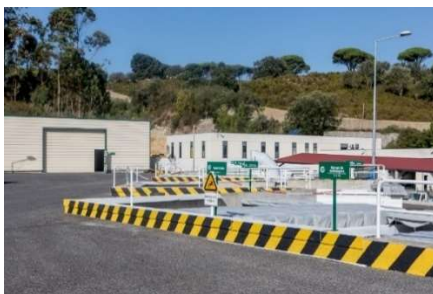
Perspectiva da plataforma de descarga do Ecocentro da Abrunheira.
