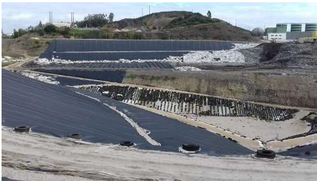
Vista geral das CCT da Abrunheira – fase de exploração.
