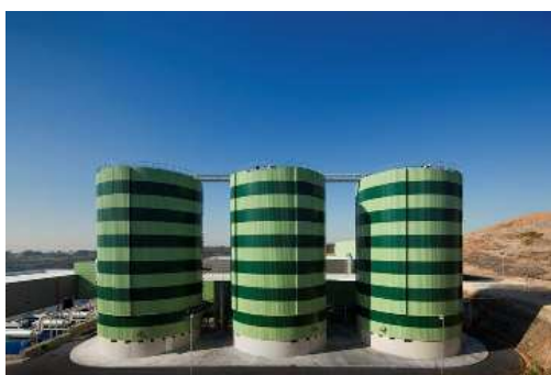
CDA da Abrunheira – vista dos biodigestores.
